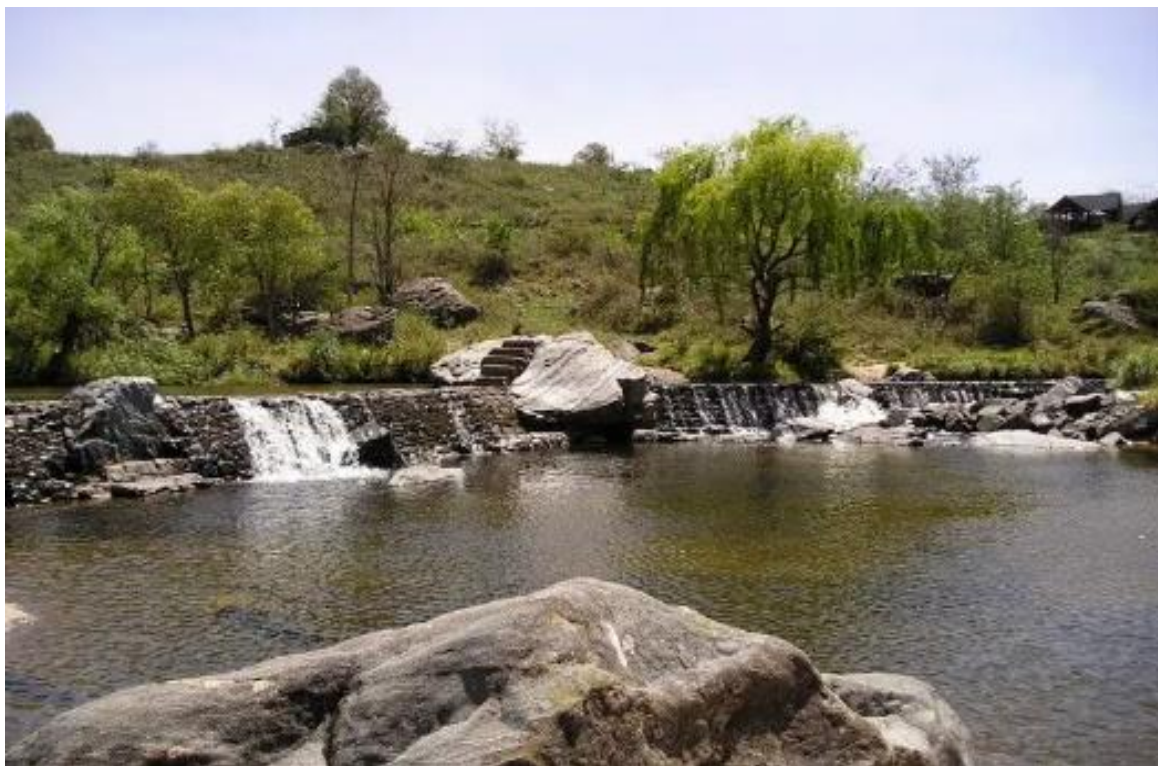
ILUSTRACIÓN 3 PRESA SOBRE EL RÍO DE LAS BARRANCAS
