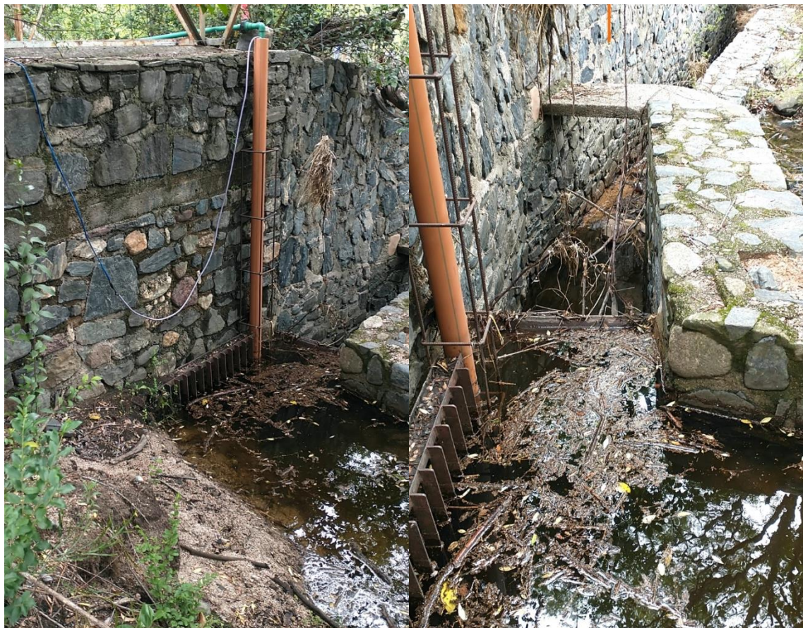
ILUSTRACIÓN 16 TOMA DE AGUA ALPA CORRAL
