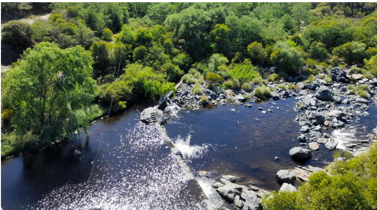
ILUSTRACIÓN 15 DIQUE DERIVADOR DE ALPA CORRAL
