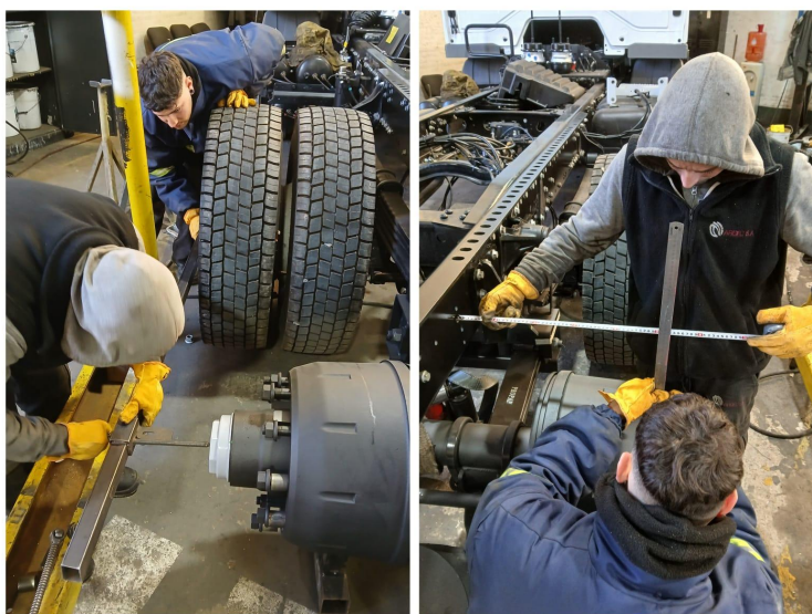
Figura N° 16: Alineación y centrado de eje
