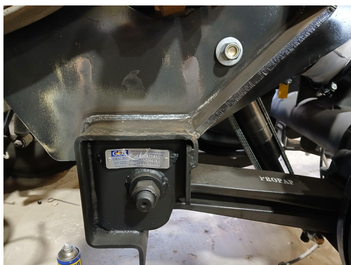
Figura N° 17: Soldado de eje
