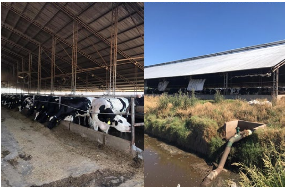
Figura 1. Tambo de producción lechera y lagunas de almacenamiento de purín.
