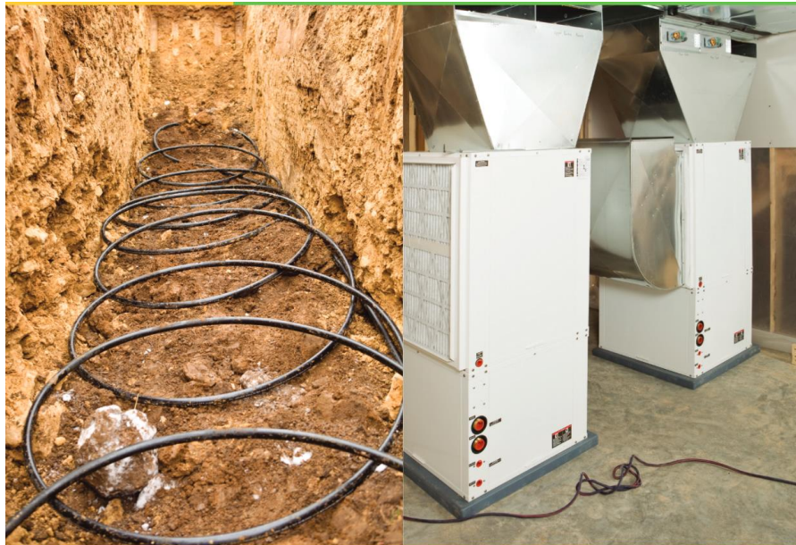
Figura 11. Los sistemas de bombas de calor geotérmicas, que consisten en el intercambiador de calor (izquierda) (IDEA, 2008) y la bomba de calor (derecha) (Clúster Eficiencia Energética Catalunya, 2019), calientan y enfrían una casa transfiriendo calor hacia y desde la tierra, respectivamente.
