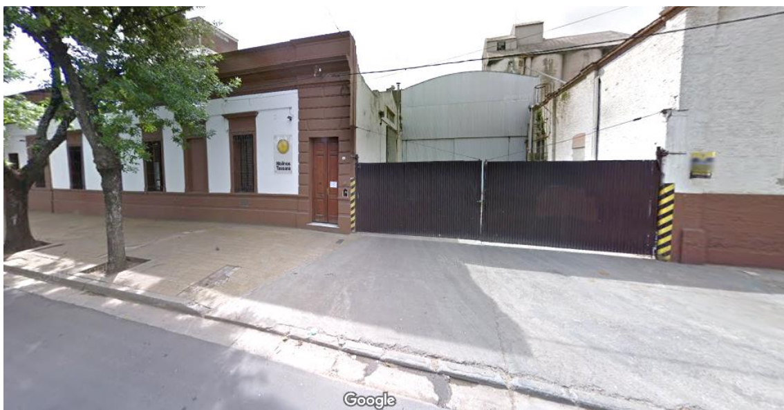
Ilustración 5: Fachada de Molinos TASSARA.
