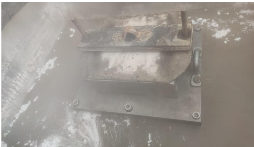
Ilustración 36-Matriceria colocada en la Cámara de vapor con carga aplicada
