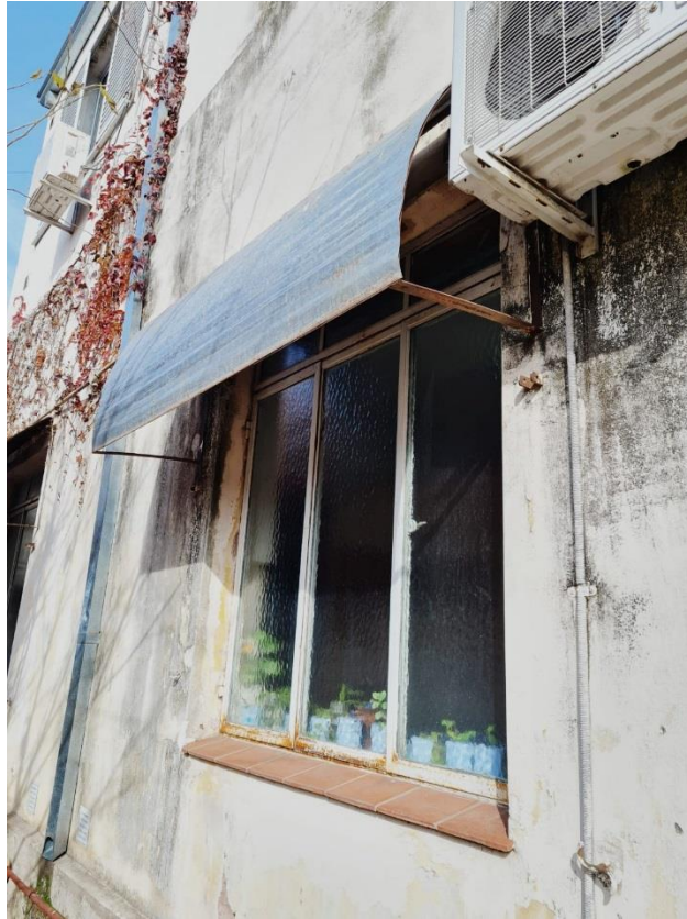
Imagen 29 - Ejemplo de techos de chapa a quitar de las ventanas del patio interno del Eva Perón.
