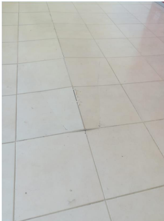
Figura 14 - Observación 1 : baldosas levantadas
