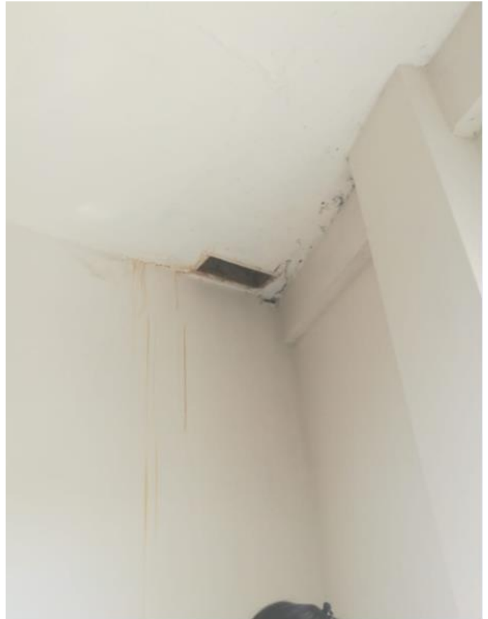
Figura 15 - Observación 2: humedad en el techo y faltante de baldosa
