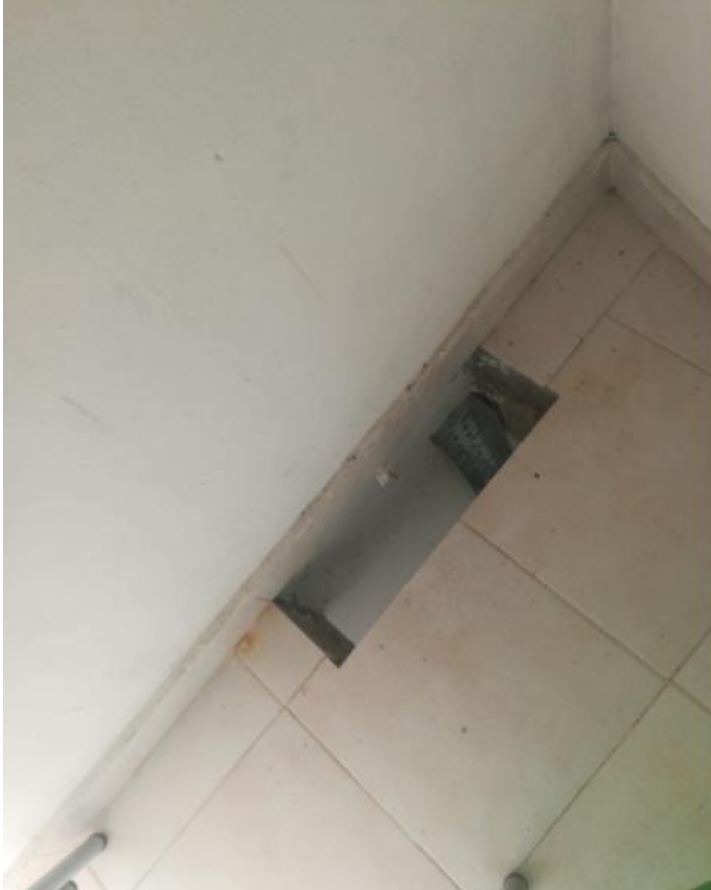
Figura 15 - Observación 2: humedad en el techo y faltante de baldosa
