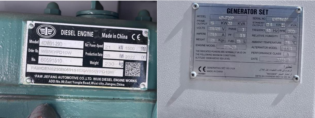
Figuras 5 y 6. Corresponden a las placas identificadoras del motor diésel y del grupo electrógeno, respectivamente.
