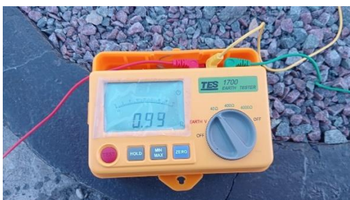
Figura 3. Procedimiento de medición de puesta a tierra con telurómetro
