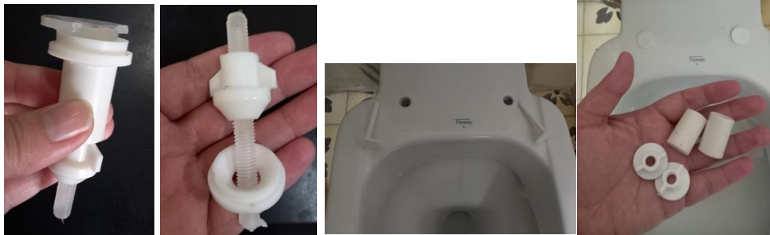
Figura 14. Artefactos que se cambiaron de inodoro en baño de mujeres. Instalación cloacal.
