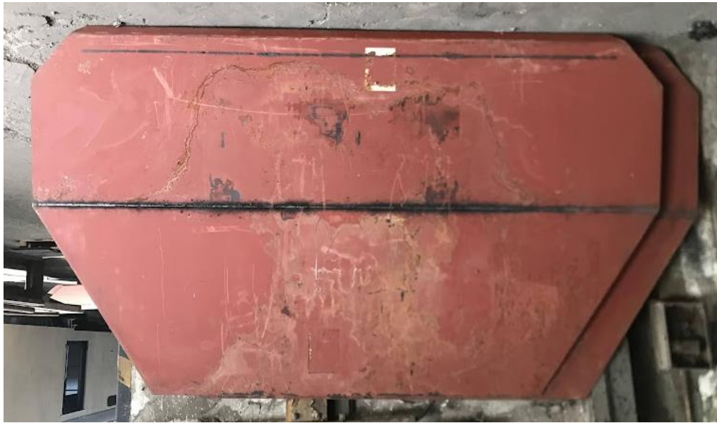
Imagen 24- Cordón de soldadura entre frente superior e inferior.
