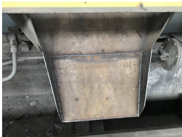
Imagen 39- Prolongación rampa fija colocada.
